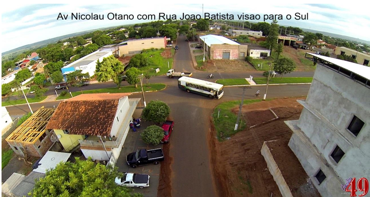
Figura 03 - Aspecto do calçamento/arruamento numa outra visão
