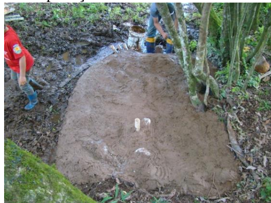
Figura 8: nascente propriedade 2 depois da aplicação da técnica solo-cimento
