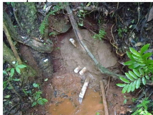
Figura 10: nascente propriedade 4 depois da aplicação da técnica solo-cimento
