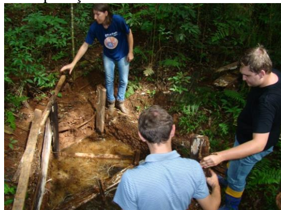
Figura 5: nascente propriedade 3 antes da aplicação da técnica solo-cimento
