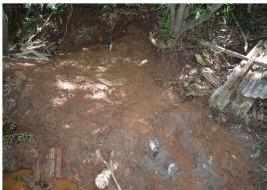
Figura 7: nascente propriedade 1 depois da aplicação da técnica solo-cimento
