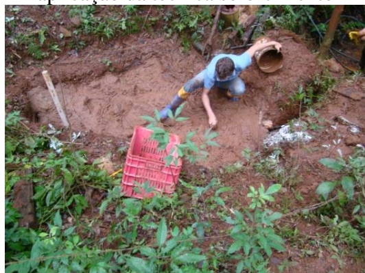
Figura 9: nascente propriedade 3 depois da aplicação da técnica solo-cimento
