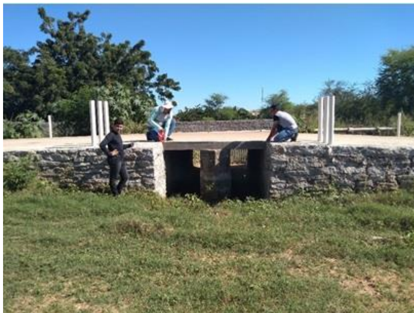
Figura 3 - Passagem molhada na ST-4.
