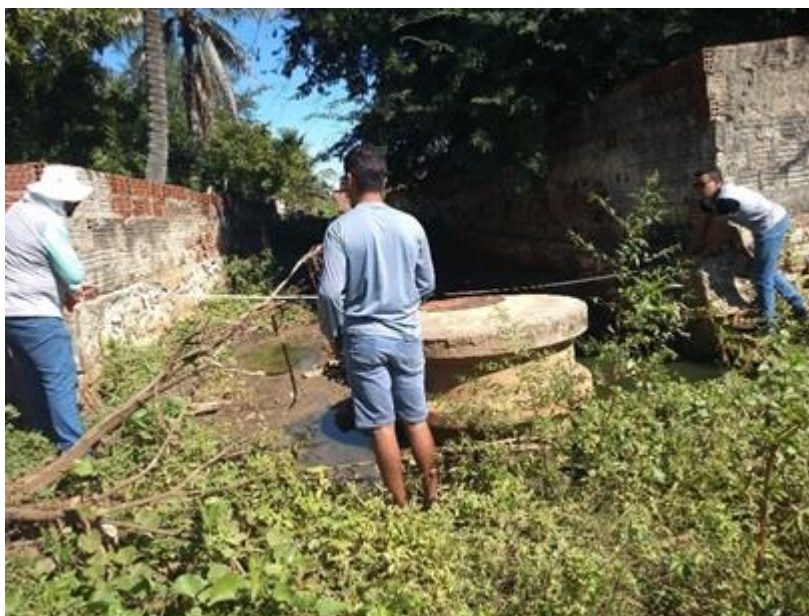
Figura 4 - Canal retelinizado por muros de residências na ST-6.
