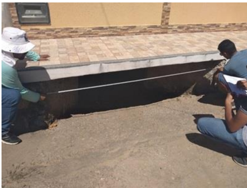
Figura 5 - Seção totalmente canalizada.
