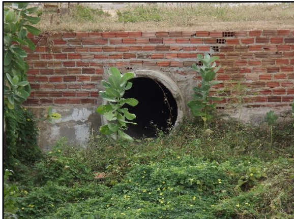
Figura 5 - Bueiro de esgoto doméstico.
