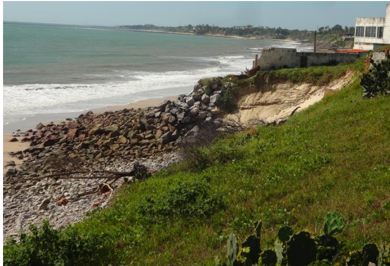
Figura 07 – Rupturas de declive com taludes nas falésias do loteamento Pacheco em Caucaia-CE.
