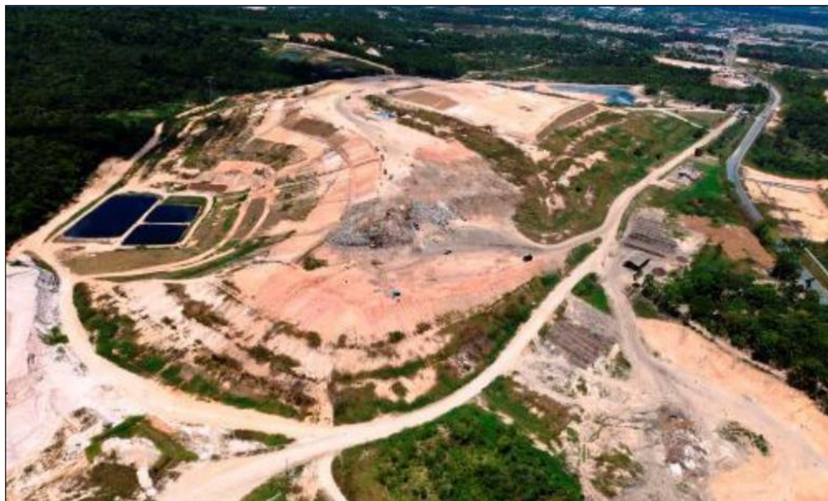
Figura 8 – Vista área do aterro municipal de Manaus-AM.
