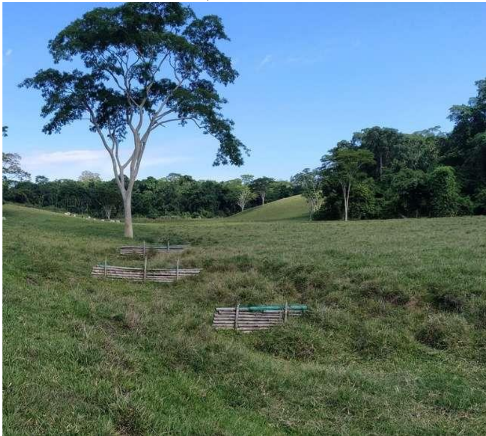
Figura 7 - Erosão estabilizada pelas paliçadas de bambu na Estância Grevilha – APA do Timburi, novembro de 2021.
