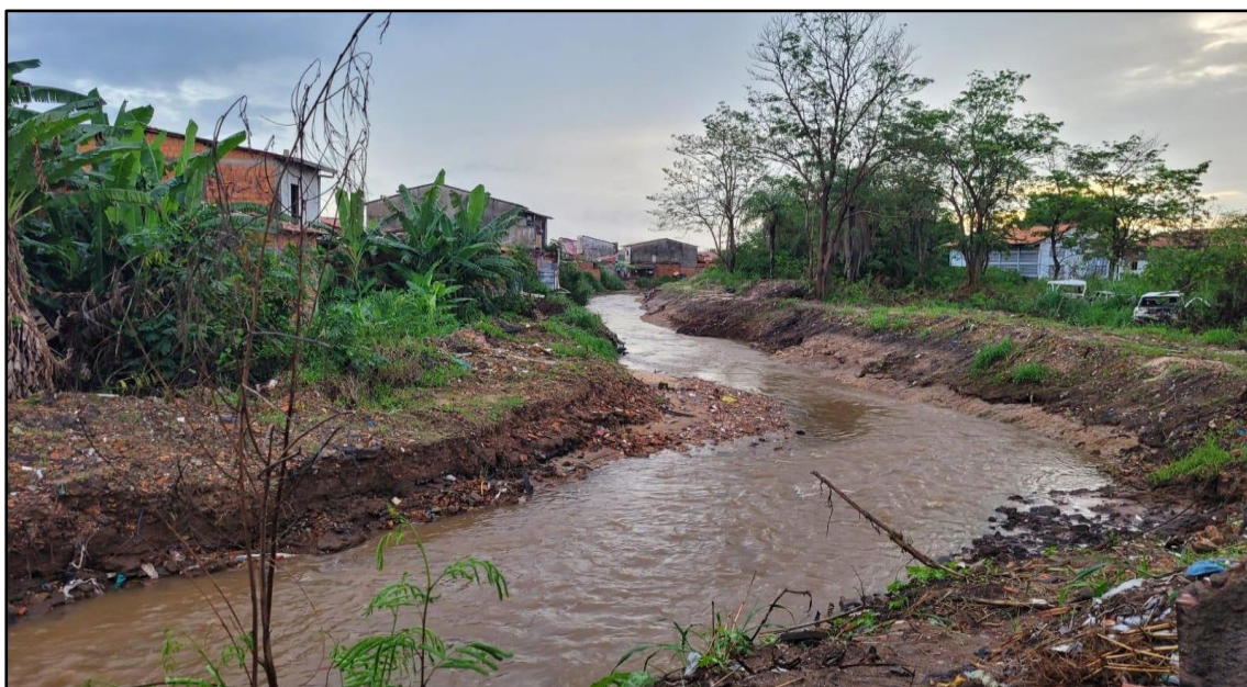
Figura 3- Construções às margens do Rio Bacuri
