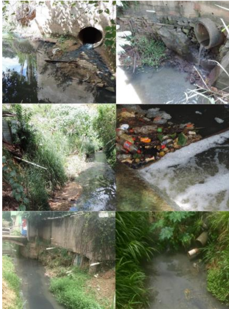
Figura 6. Pontos de lançamento de esgoto e presença de resíduos sólidos no córrego Cantagalo, Três Rios, RJ.
