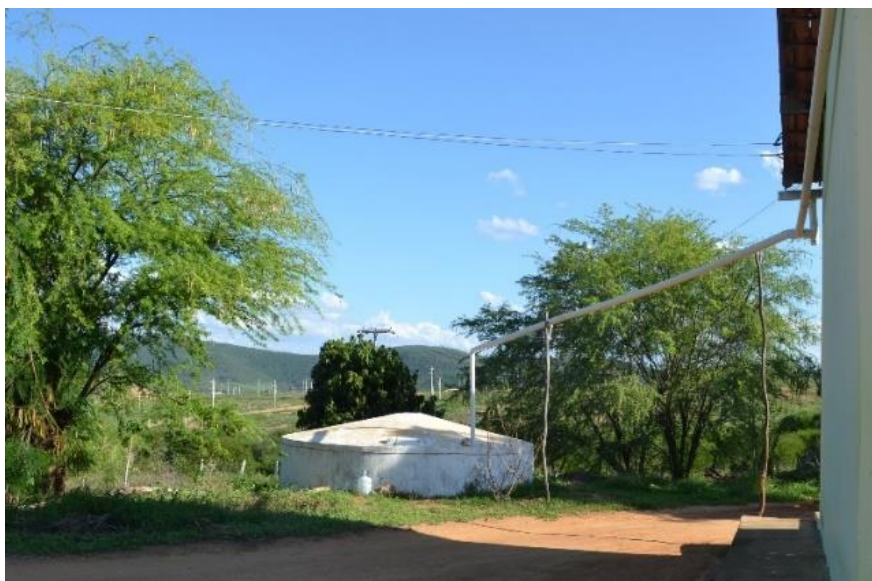
Figura 6 – Cisterna instalada em uma comunidade camponesa de Anagé-BA
