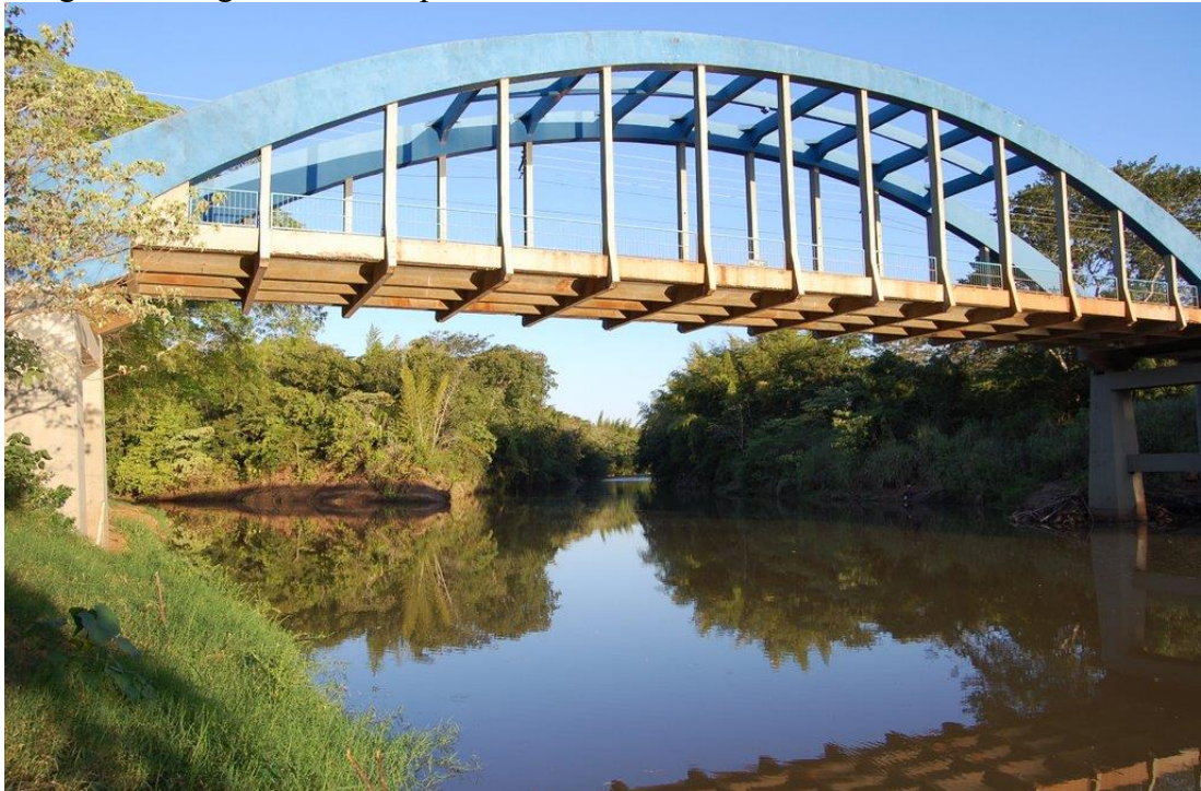
Imagem 5. Imagem atual da “ponte velha 5 ” .
