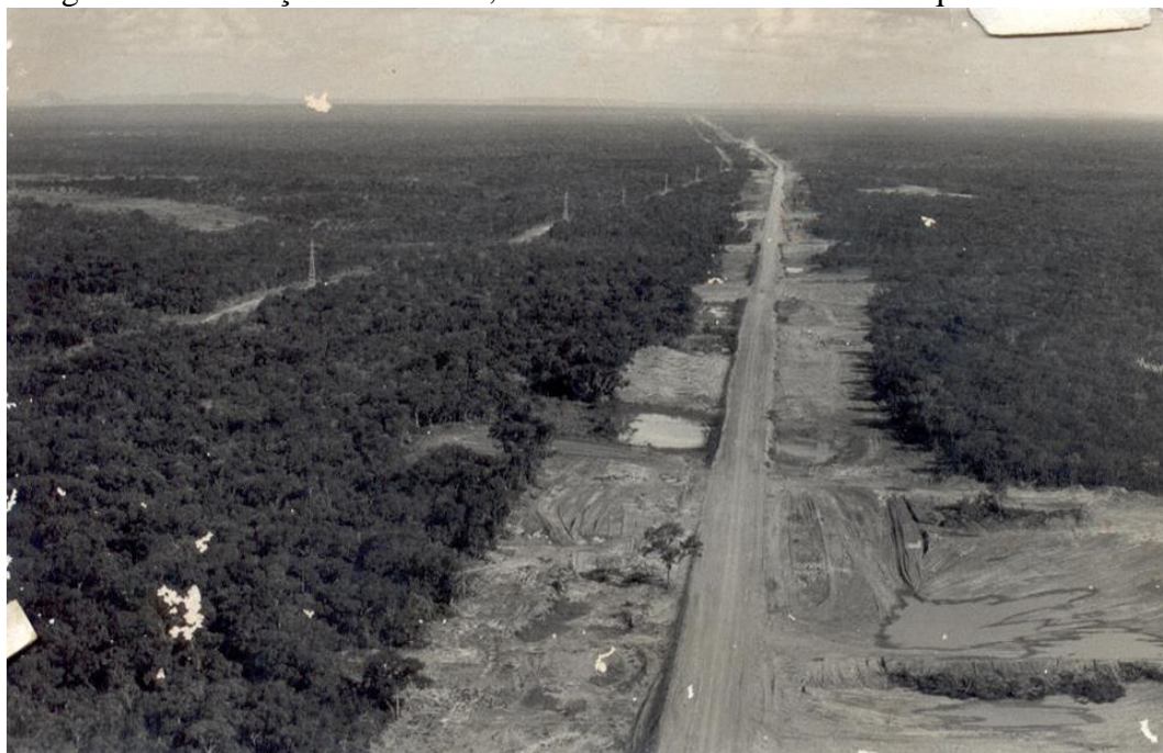
Imagem 8. Construção da BR-262, em 1973. Trecho Miranda - Aquidauana.
