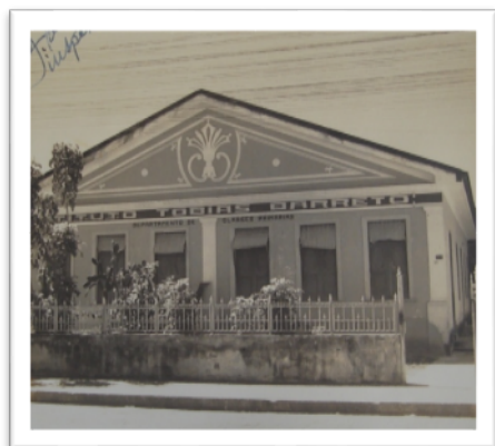
Figura 6. Edifício 3 do Colégio Tobias Barreto.
