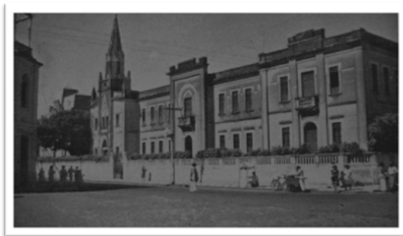
Figura 14. Fachada do Colégio Nossa Senhora de Lourdes (1951).
