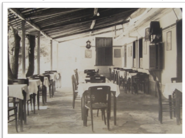
Figura 11. Vista parcial do refeitório do Colégio Tobias Barreto (Edifício 2).
