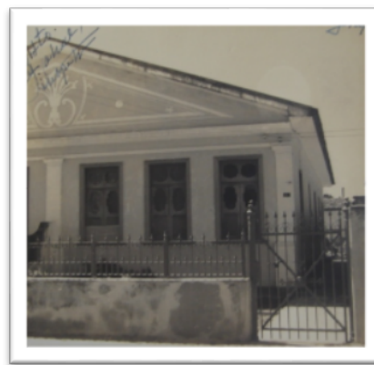
Figura 7. Edifício 4 do Colégio Tobias Barreto.
