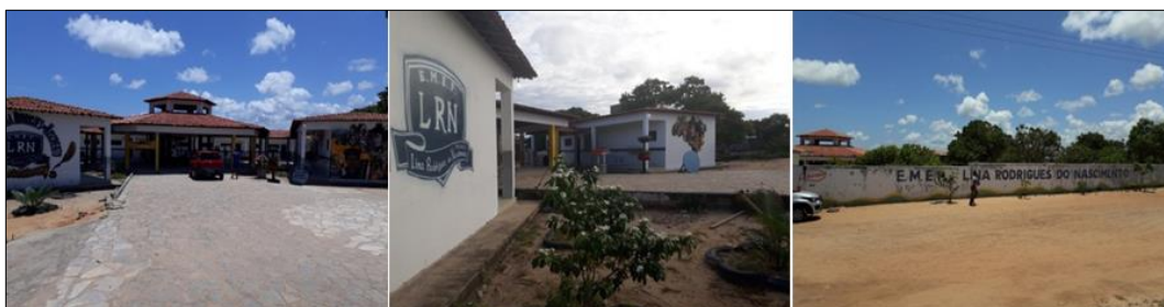
Figura 1 – Escola Municipal de Ensino Fundamental Prof. a Lina Rodrigues do Nascimento (Fachada da Unidade Educacional – LRN (IPIRANGA))
